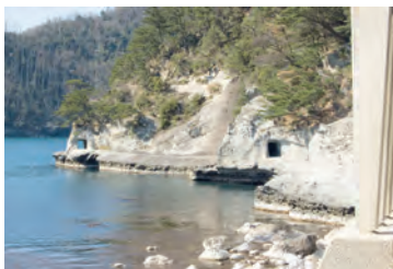
福浦トンネル
